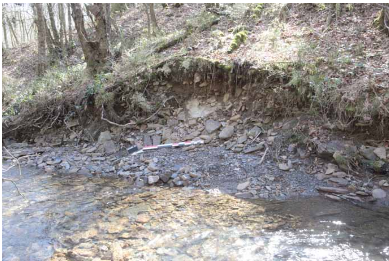
Fig.40 Digue endommagée par la crue d'octobre 2024 (cliché CARA, Maxence Pieters).
