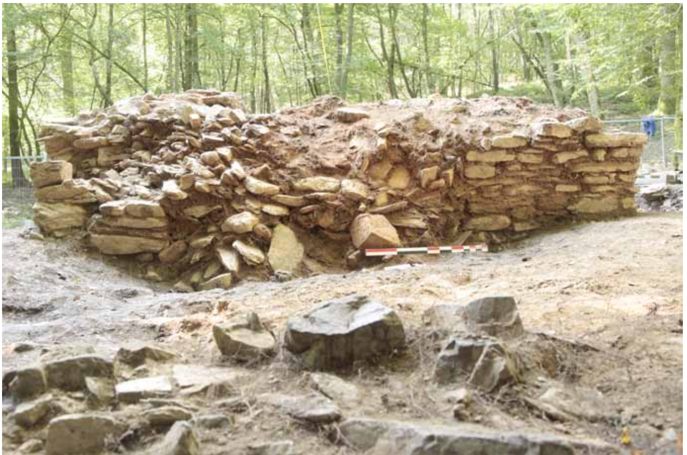
Fig.17 Vue de l'embrasure de travail avant enlèvement des restes de l'effondrement. On remarque à l'est le basculement des pierres du massif vers l'intérieur et au premier plan un claveau en pierre de Dom (cliclé CARA, Maxence Pieters).
